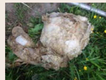
Diese und ähnliche Bilder sehen wir vermehrt bei Reparaturen von verstopften Pumpen.
